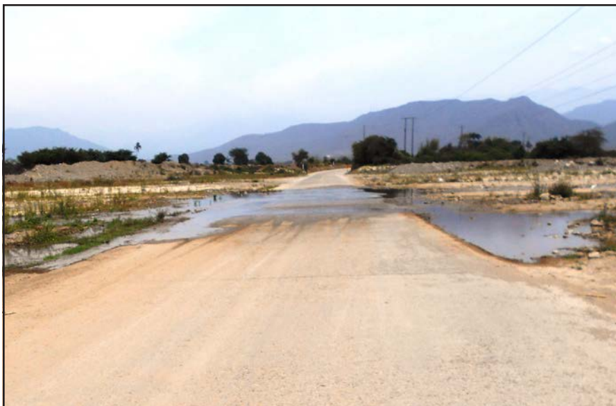
Badén Nanchoc (Km. 45+455), Nueva Arica.
