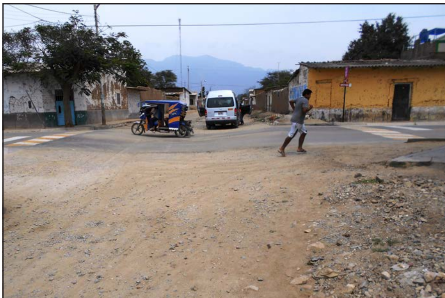
Badén urbano (Km. 42+060), Nueva Arica.
