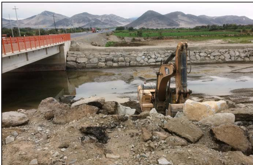
Vistas del procedimiento de enrocado del río (protección ribereña)
