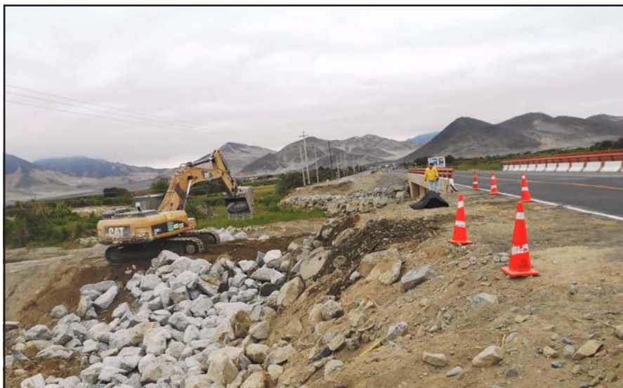
Los trabajos se efectuaron 100 m aguas arriba y 100 m aguas abajo del río Huambacho desde el puente del mismo nombre.
