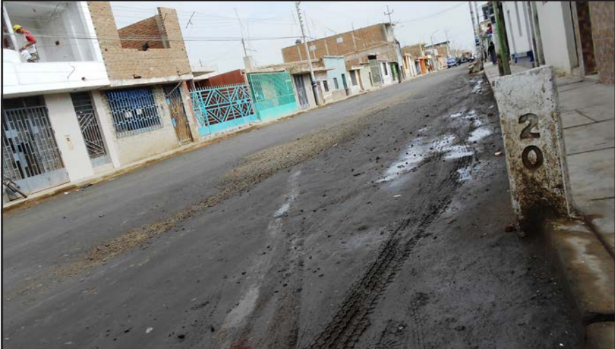
Km. 19+700 al 20 (Túcume) Zona urbana. No hay pavimento, pero es transitable.
