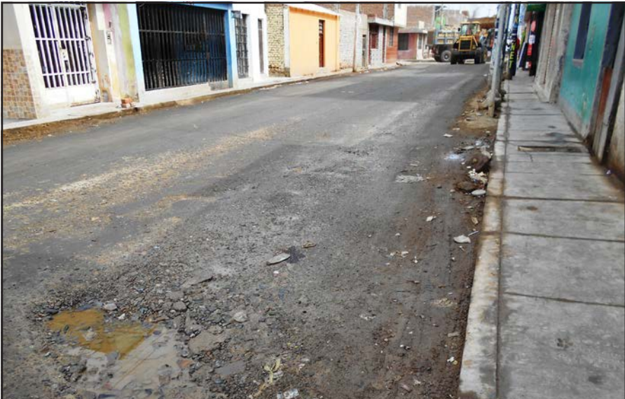
La Municipalidad Distrital de Túcume cubrió la superficie con cloruro de sodio.
