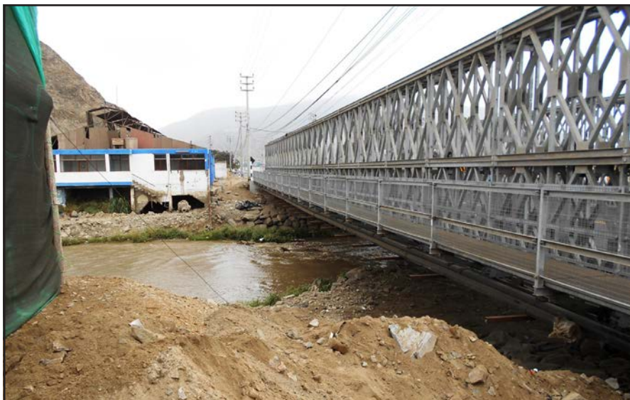
Puente provisional instalado en la zona de Coishco.
